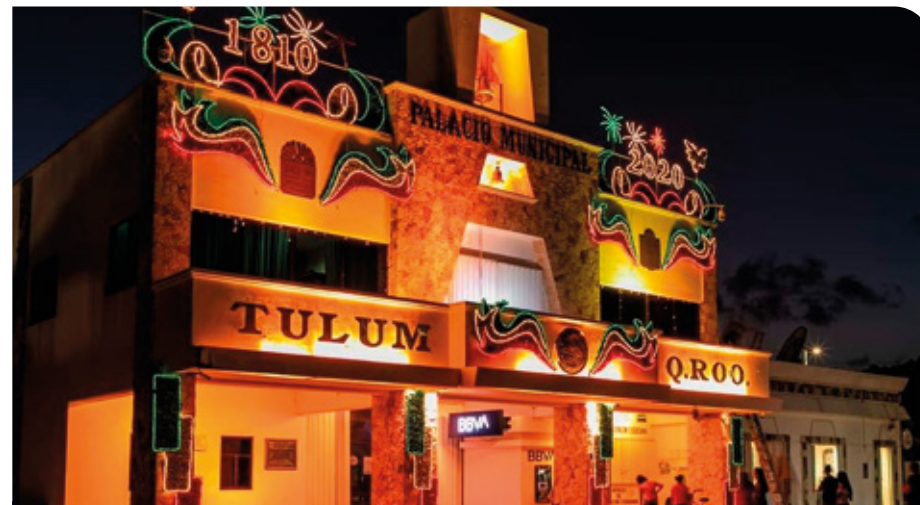
Tulum, Q.R. Luminaria: LUMA-FORLED-POSEIDON
